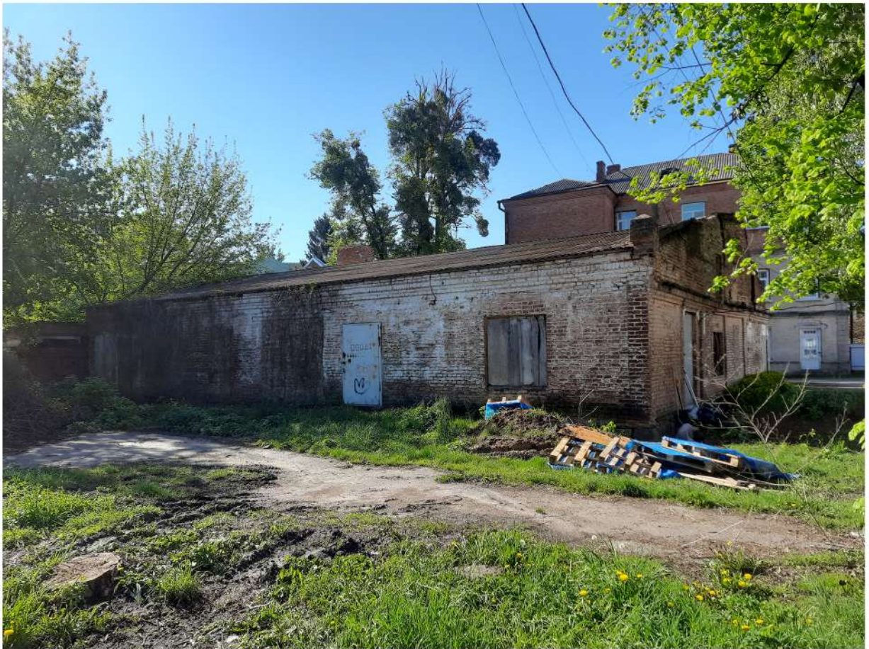
Рис. 4. Загальний вигляд об'єкта, що досліджувався. Вид з півночі.
