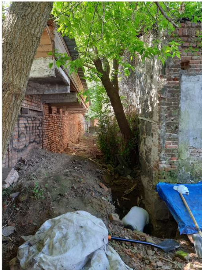
Рис. 5. Загальний вигляд об'єкта, що досліджувався. Вид з півночі.
