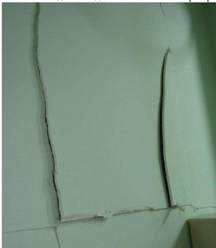
Рисунок 5.9 - Пошкодження підвісної стелі системи «Армстронг» Г-Д, 9-13
