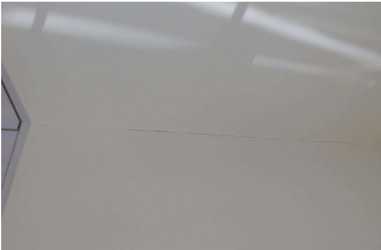
Рисунок 4.4 – Горизонтальна тріщина по опорядженню стіни в осях Е, 12-13 (приміщення №28)
