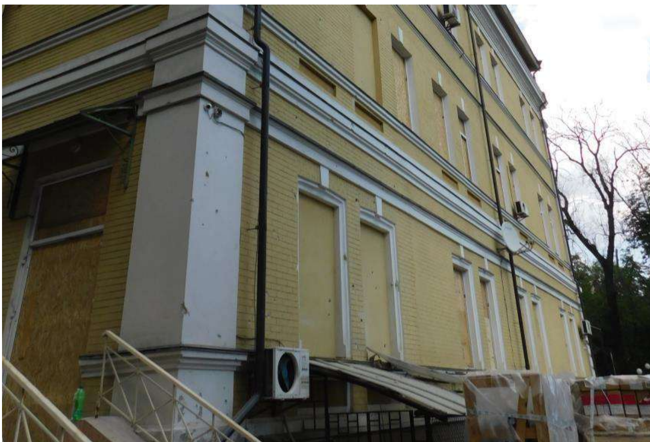
Рисунок 8.15 – Ділянки пошкодження опорядження фасаду в осях 1, Е-Д
