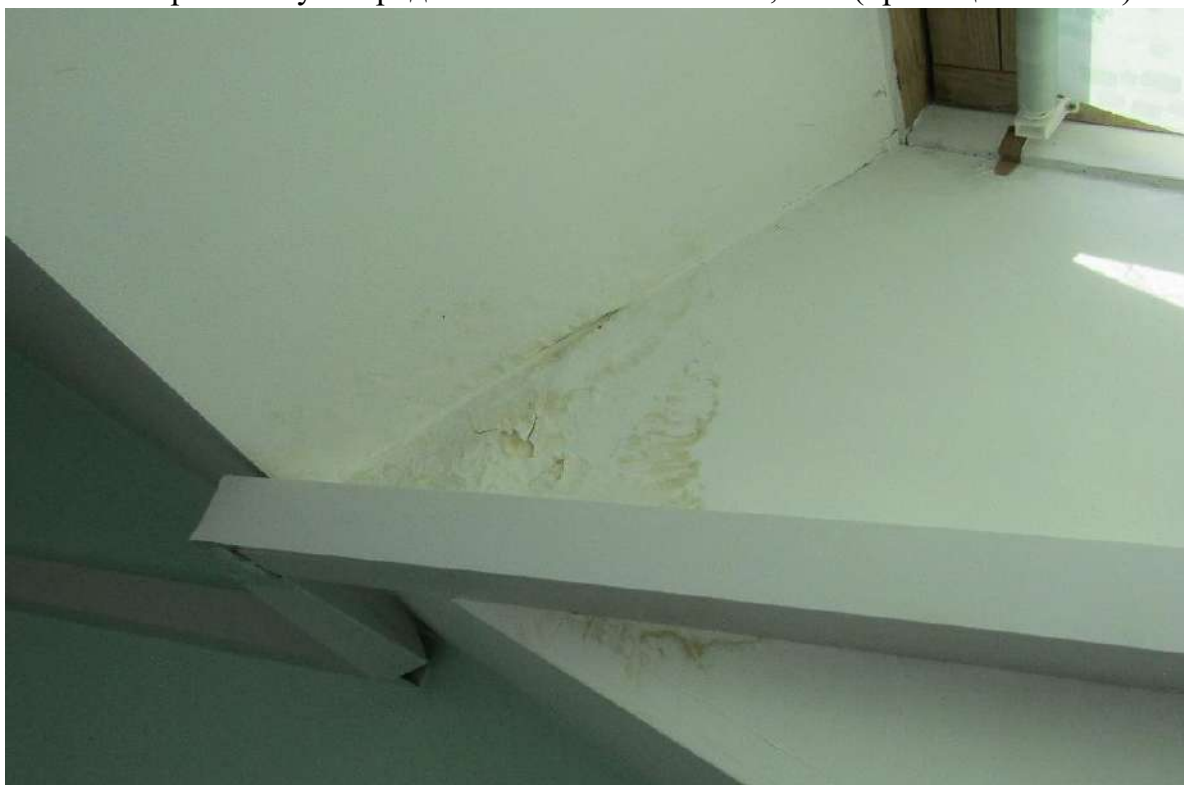
Рисунок 7.16 – Пошкодження віконного заповнення. Утворення тріщин по гіпсокартонному опорядженню стелі в осях Б-Г, 7'-8 (приміщення №21)
