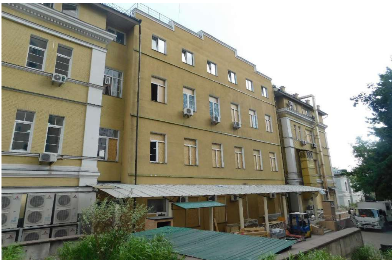
Рисунок 8.7 - Загальний вигляд фасаду в осях Е,11-1 з пошкодженими віконними заповненнями
