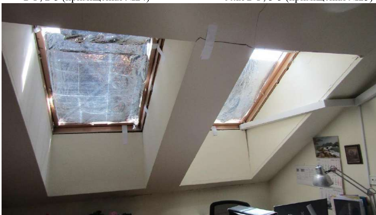
Рисунок 7.11 – Утворення тріщин по стиках гіпсокартонного опорядження стелі в осях Б-Г, 2-3 (приміщення №24)
