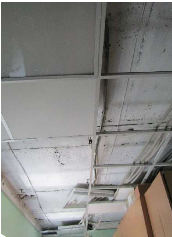
Рисунок 6.10 – Ділянка руйнування/пошкодження системи кріплення підвісної стелі типу армстронг в осях Б-Г, 1-2 (приміщення №40)
