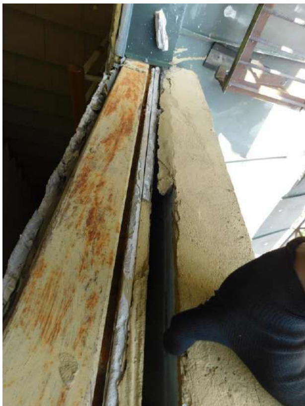
Рисунок 8.23 – Пошкодження та деформація опорядження стіни в місці розташування технічного отвору для доступу на покрівлю зі сторони бокового фасаду в осях 1, Е-А
