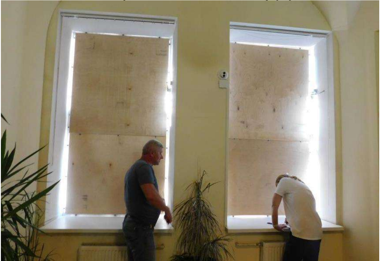
Рисунок 3.1 – Зруйновані/відсутні віконні заповнення в осях Г-Д, 1-2 (приміщення №3)
