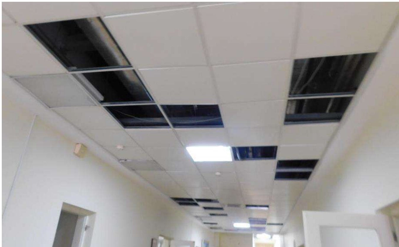
Рисунок 4.8 – Ділянка деформації/пошкодження системи кріплення підвісної стелі типу армстронг в осях Г-Д, 1-6 (приміщення №2)
