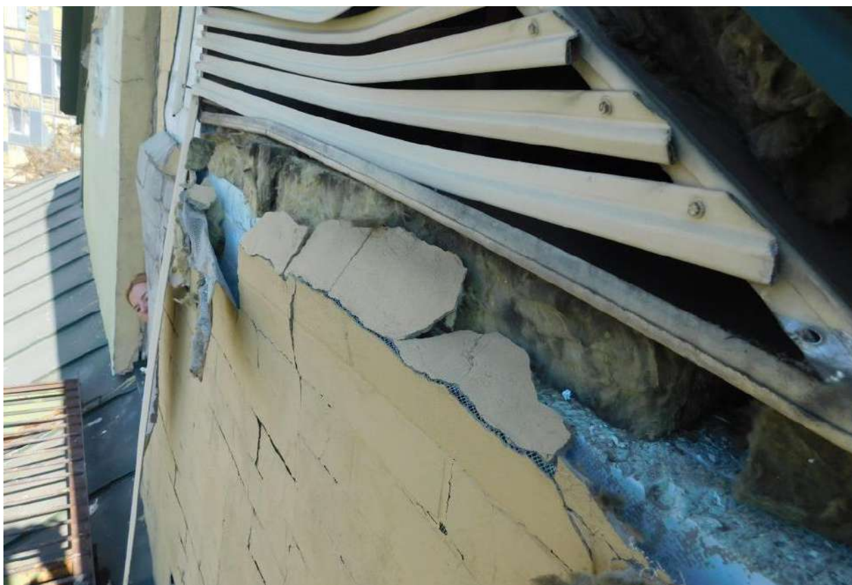
Рисунок 8.21 – Ділянки пошкодження опорядження та вентиляційних решіток зі сторони бокового фасаду в осях 1, Е-А
