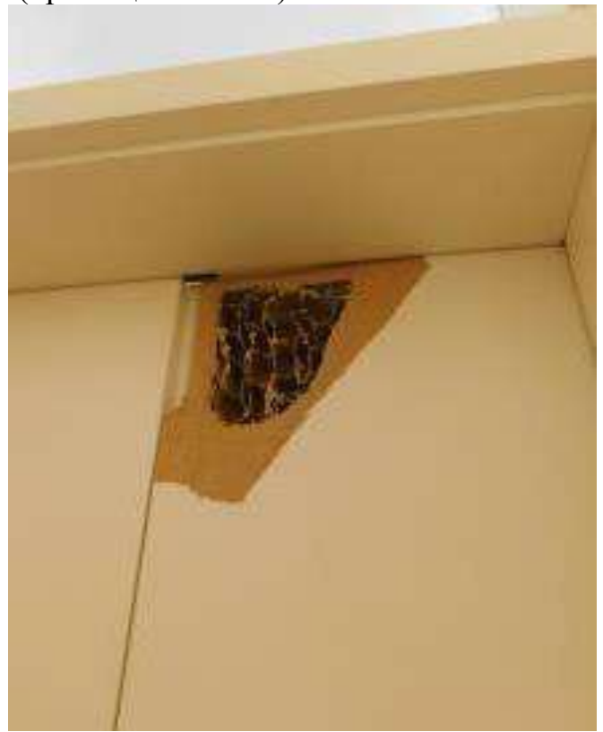
Рисунок 4.1 – Ділянка деформації/пошкодження системи кріплення підвісної стелі типу армстронг в осях Б/1-Г (приміщення №30)
