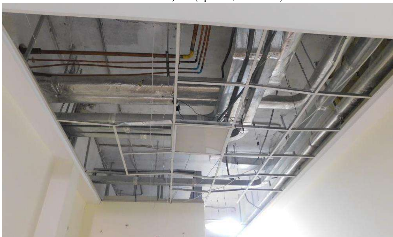
Рисунок 4.12 - Ділянка руйнування системи кріплення підвісної стелі типу армстронг в осях В/Г-Г, 3-4 (приміщення №56)
