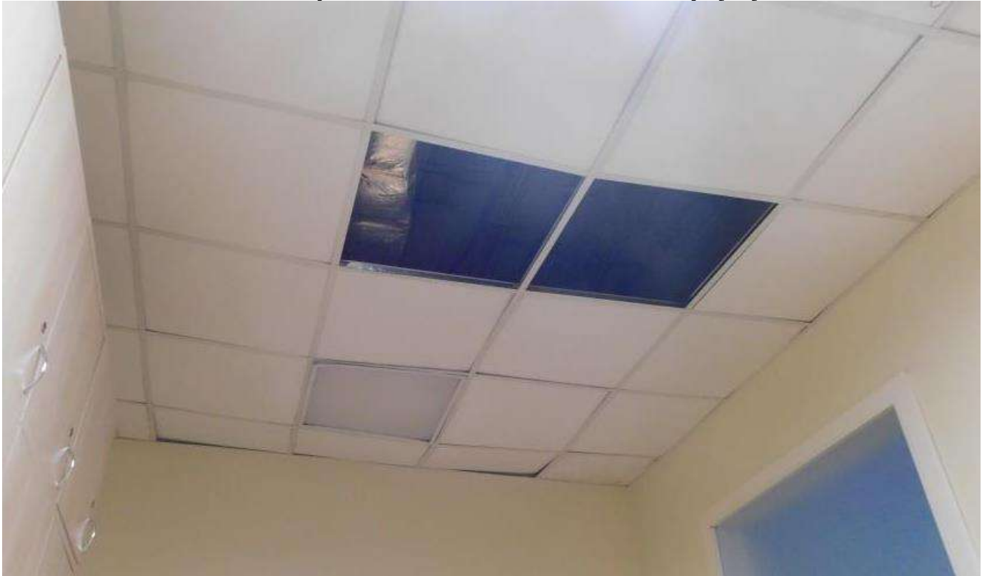
Рисунок 4.1 – Ділянка деформації/пошкодження системи кріплення підвісної стелі типу армстронг в осях Б/1-Г (приміщення №30)
