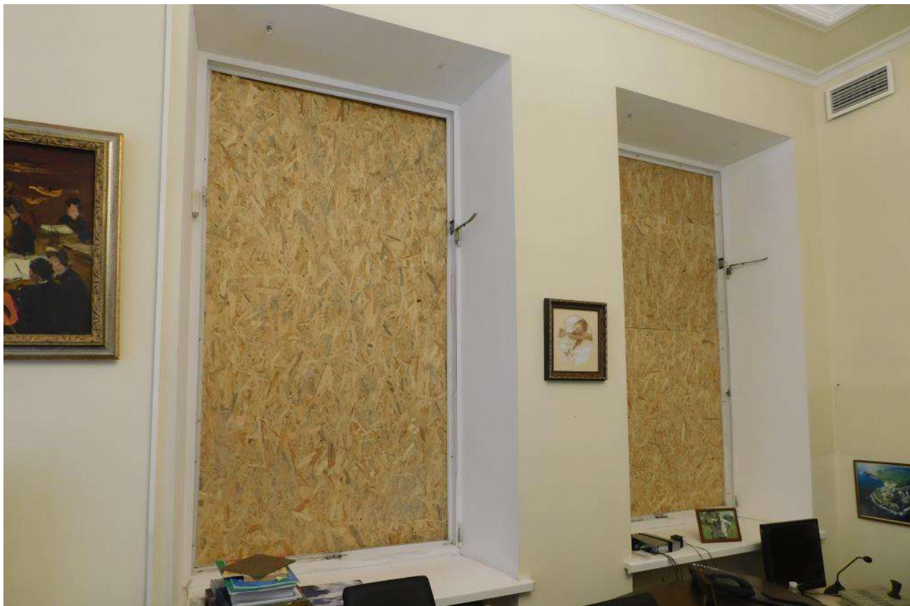
Рисунок 3.21 – Зруйновані/відсутні віконні заповнення в осях 1, А-Б/1 (приміщення №11)
