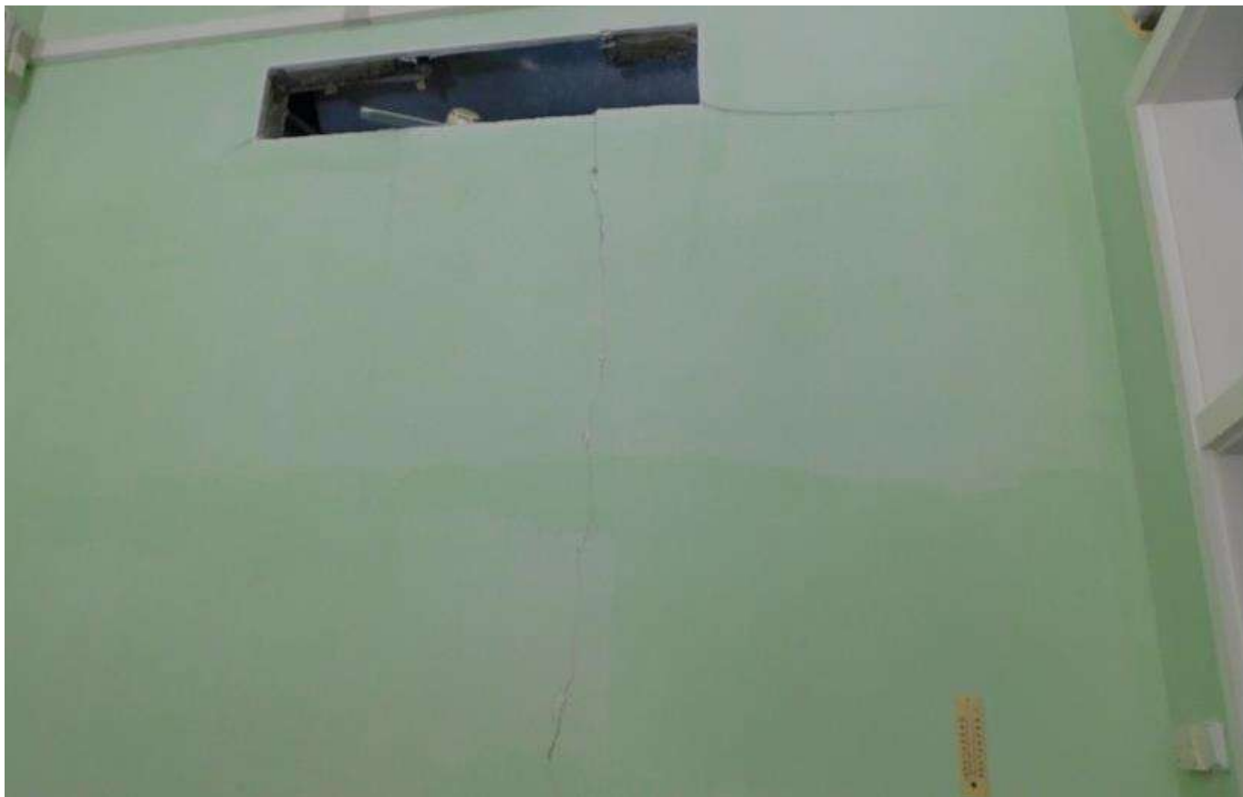
Рисунок 4.10 – Деформація гіпсокартонної перегородки з утворенням тріщин в осях В/Г-Г, 3-4 (приміщення №55, 56)
