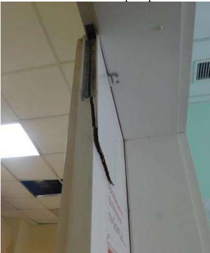
Рисунок 4.1 – Ділянка деформації/пошкодження системи кріплення підвісної стелі типу армстронг в осях Б/1-Г (приміщення №30)
