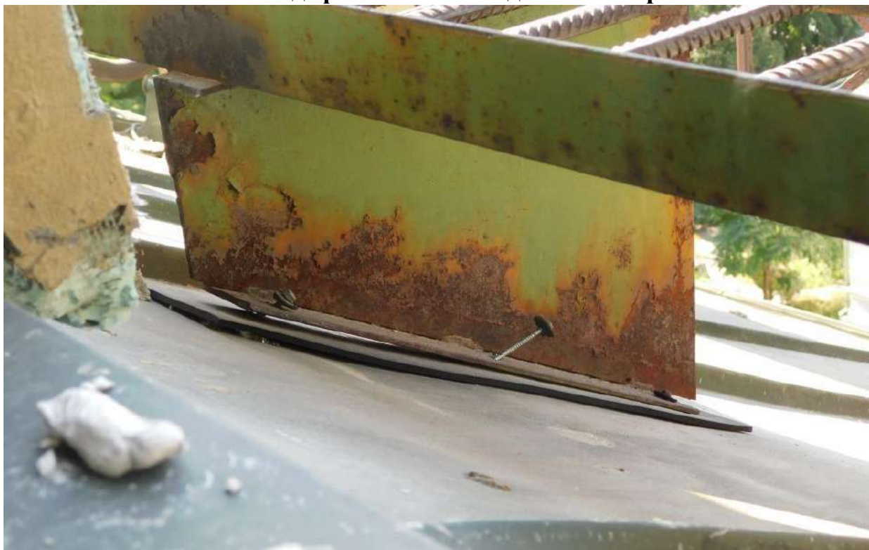
Рисунок 8.17 – Деформація кріплень металевих пішохідних доріжок, утворення корозії та пошкодження захисного шару металу зі сторони бокового фасаду в осях 1, Е-А
