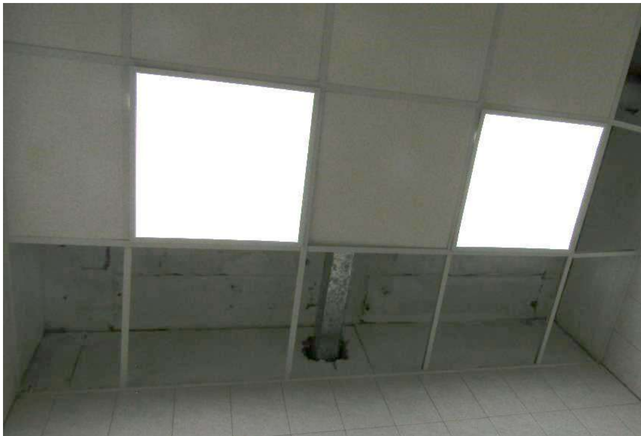
Рисунок 5.11 - Пошкодження підвісної стелі системи «Армстронг» Д-Е, 2-4
