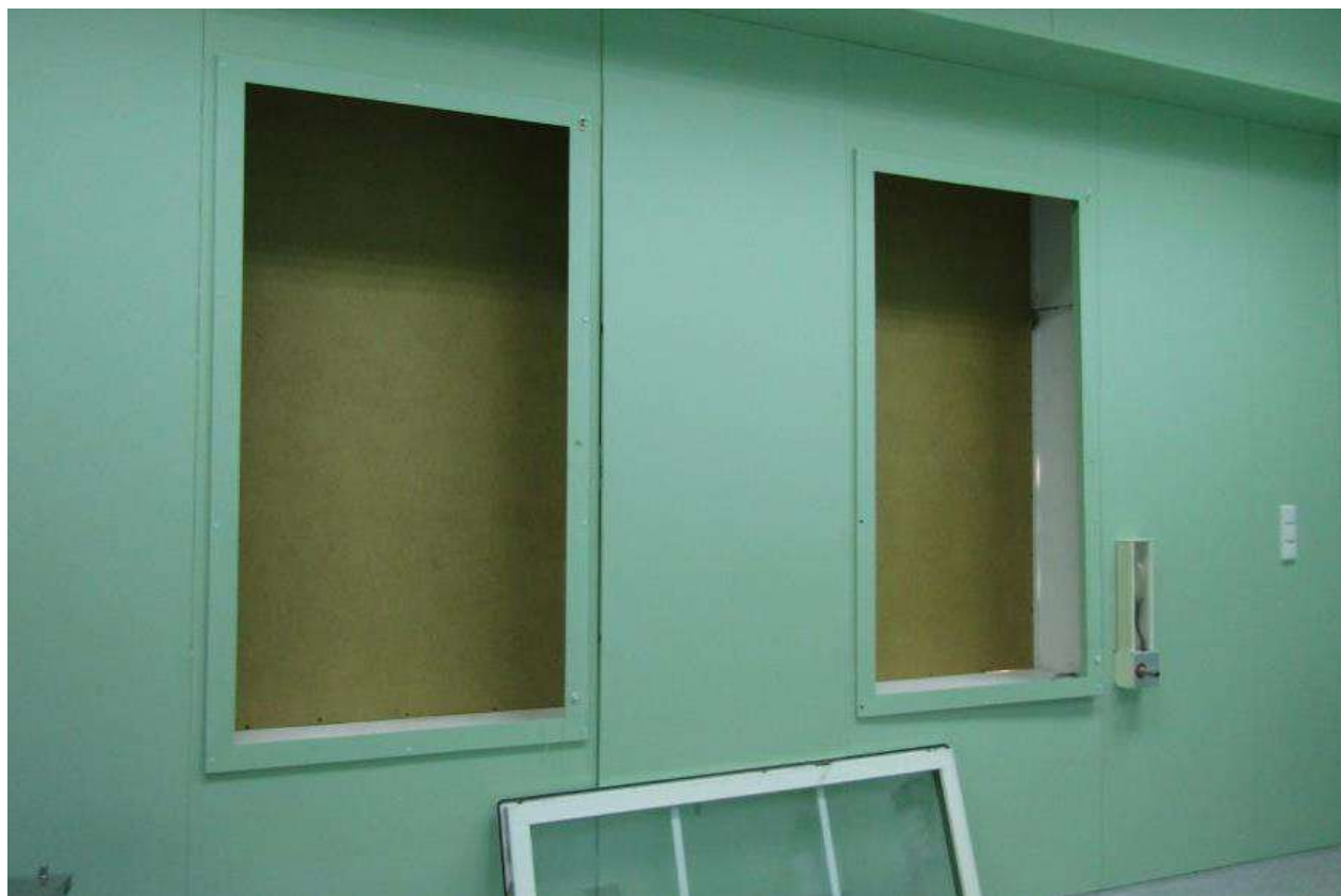
Рисунок 5.13 - Пошкоджене віконне заповнення (скління) та рама в осях 1, Б/1-Г
