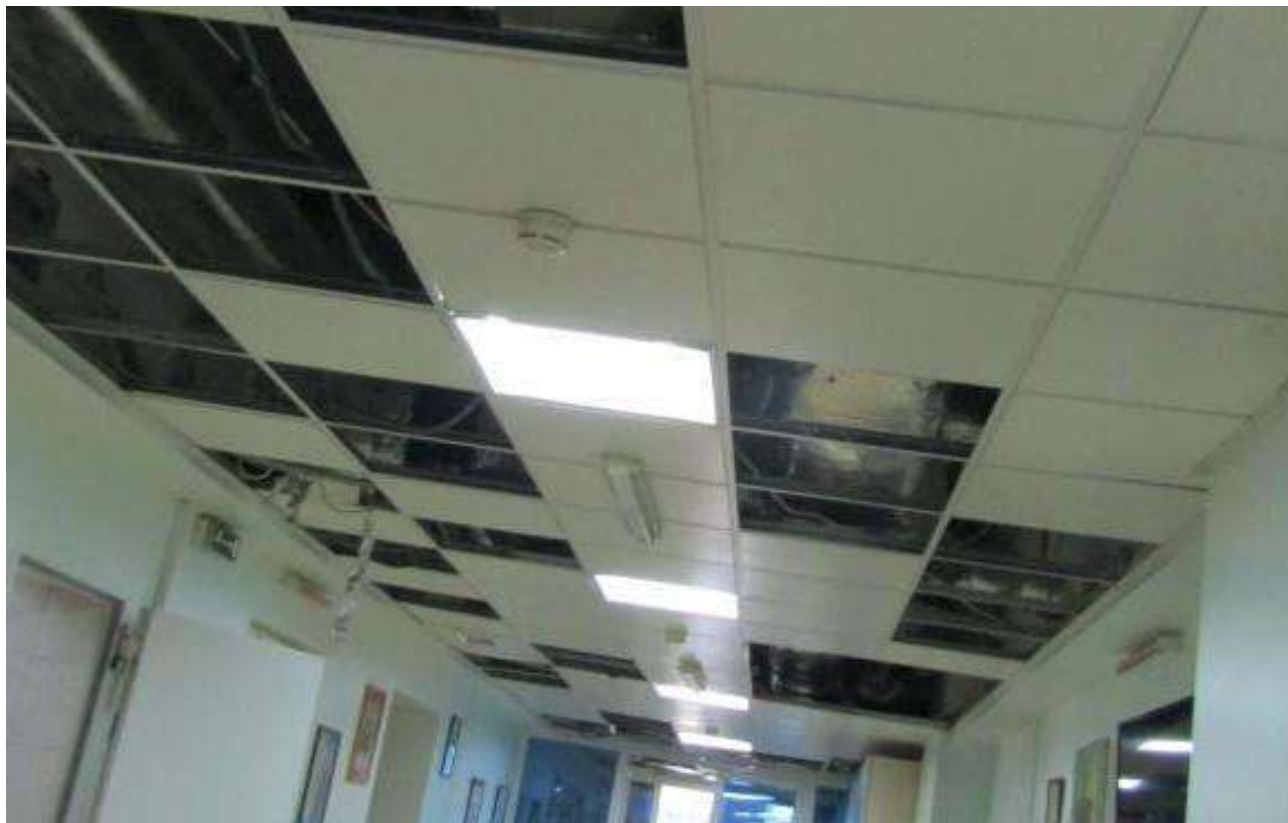
Рисунок 5.7 - Пошкодження підвісної стелі системи «Армстронг» Г-Д, 5-8
