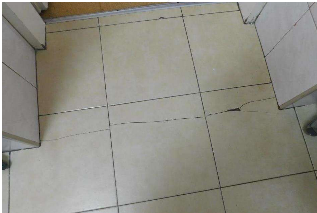
Рисунок 4.4 – Горизонтальна тріщина по опорядженню стіни в осях Е, 12-13 (приміщення №28)
