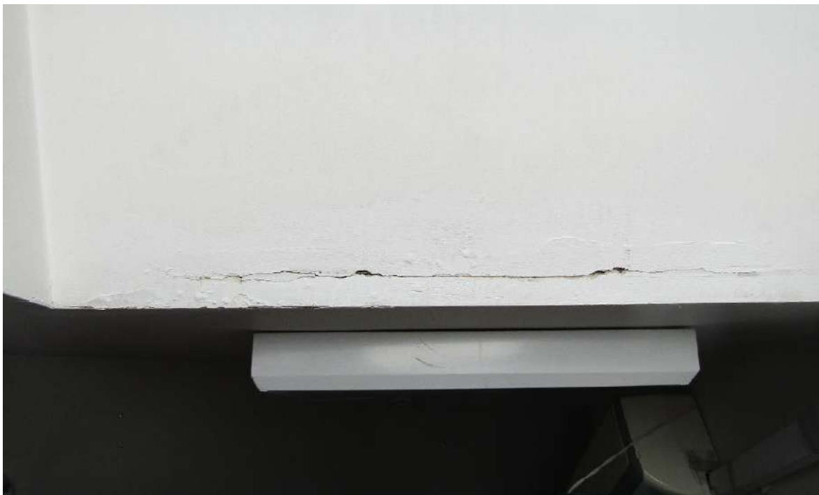
Рисунок 7.18 – Утворення тріщини по гіпсокартонному опорядженню стелі в осях Б-Г, 11-12 (приміщення №19)
