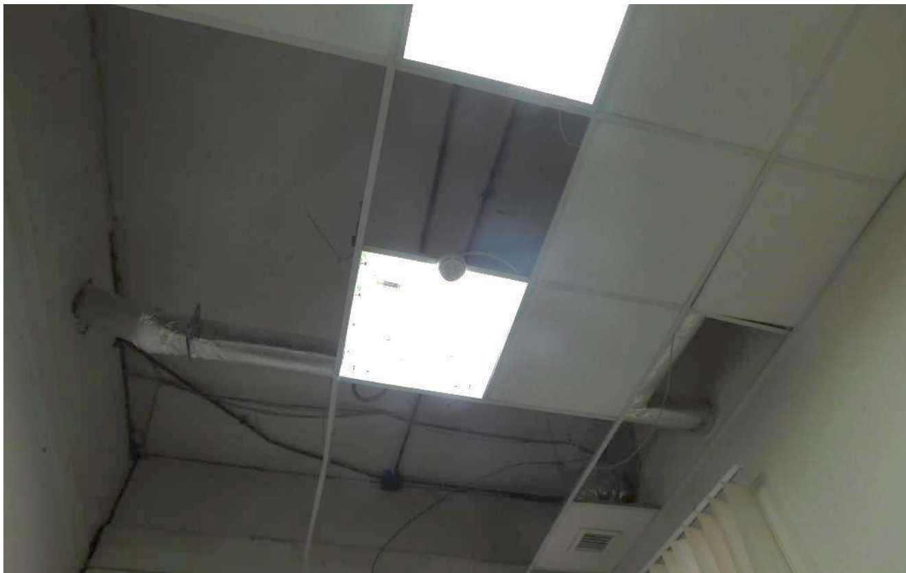
Рисунок 3.5 – Ділянка руйнування/пошкодження системи кріплення підвісної стелі типу армстронг в осях Д-Е, 3-4 (приміщення №23)
