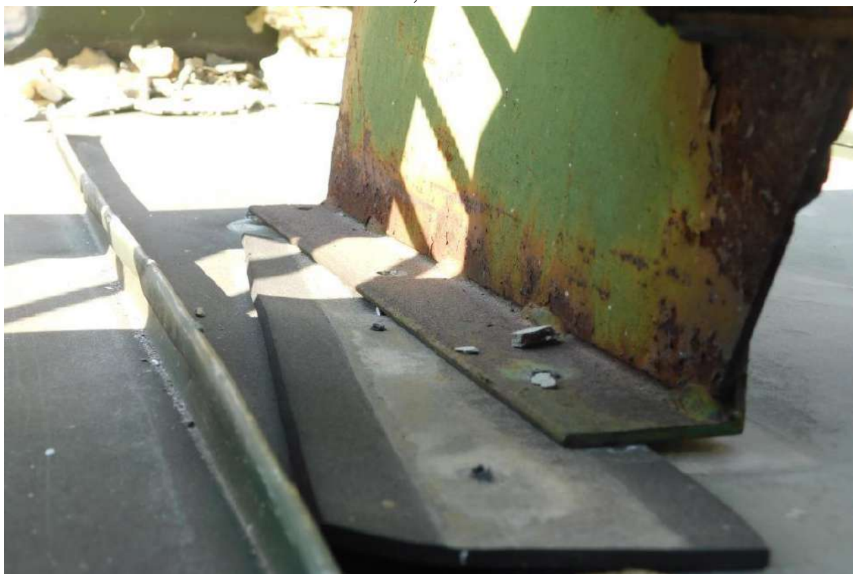
Рисунок 8.17 – Деформація кріплень металевих пішохідних доріжок, утворення корозії та пошкодження захисного шару металу зі сторони бокового фасаду в осях 1, Е-А
