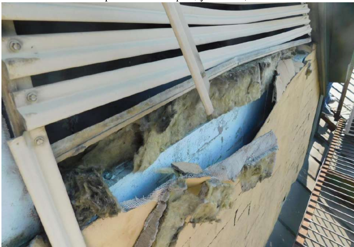
Рисунок 8.21 – Ділянки пошкодження опорядження та вентиляційних решіток зі сторони бокового фасаду в осях 1, Е-А
