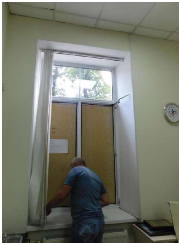
Рисунок 3.18 – Пошкоджене віконне заповнення в осях А, 2-3 (приміщення №9)
