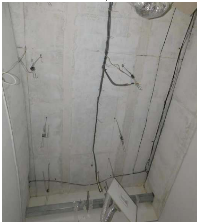
Рисунок 3.17 – Деформована підвісна система типу армстронг в осях А-Г, 2-3 (приміщення №9)
