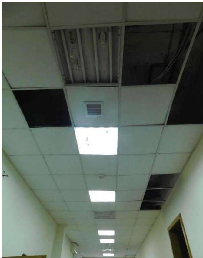
Рисунок 3.17 – Деформована підвісна система типу армстронг в осях А-Г, 2-3 (приміщення №9)
