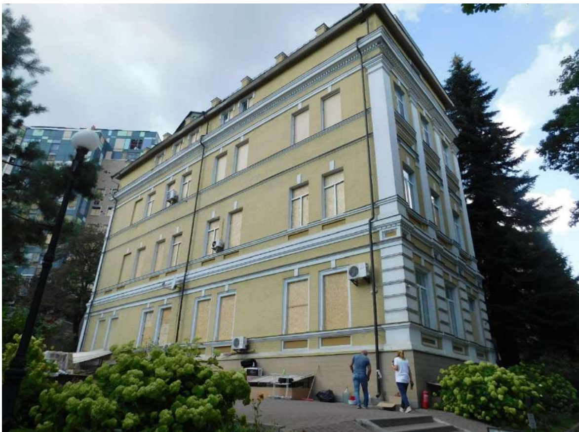
Рисунок 8.4 -Загальний вигляд фасаду в осях А-Е,1 з пошкодженими віконними заповненнями
