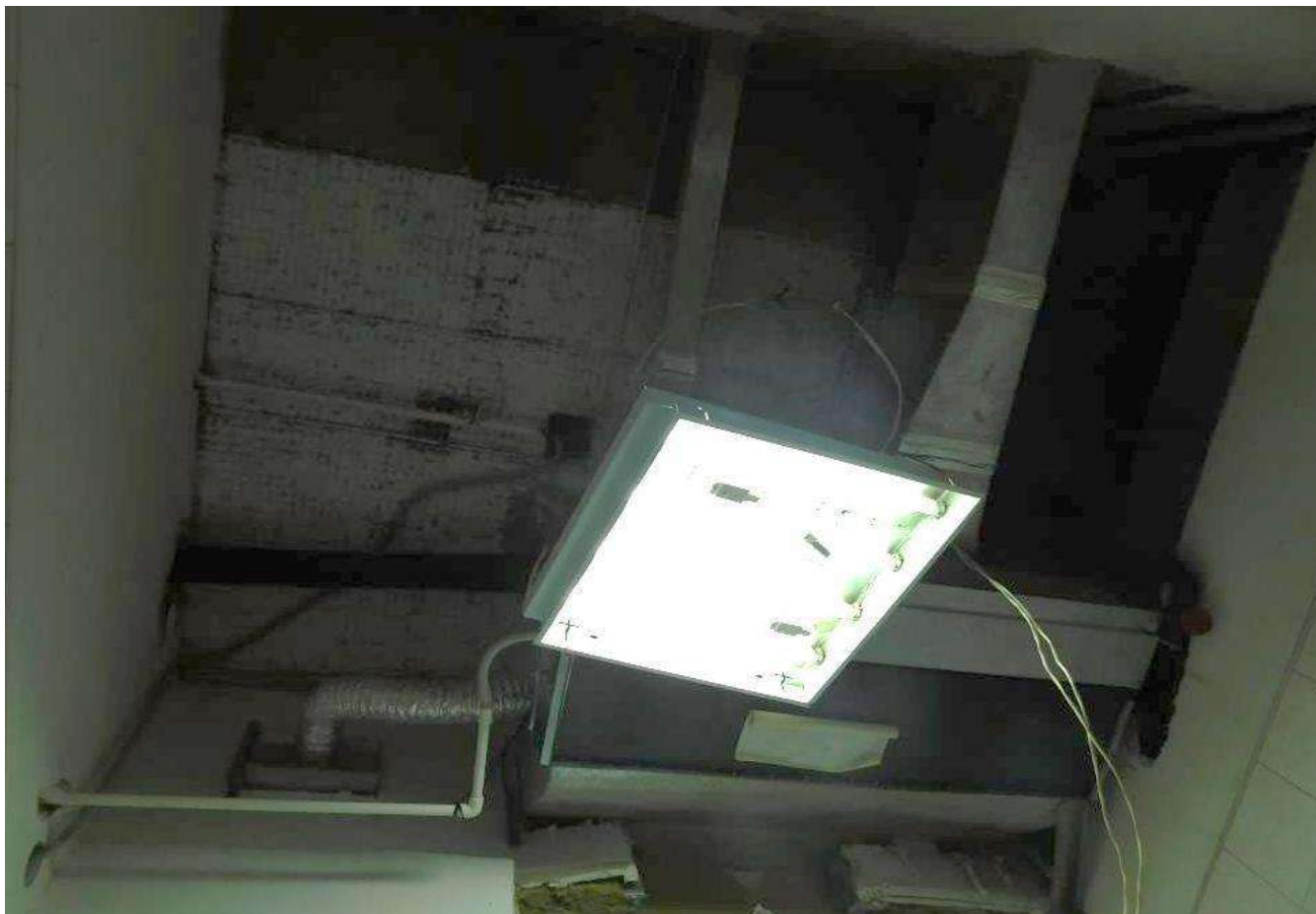
Рисунок 4.12 - Ділянка руйнування системи кріплення підвісної стелі типу армстронг в осях В/Г-Г, 3-4 (приміщення №56)
