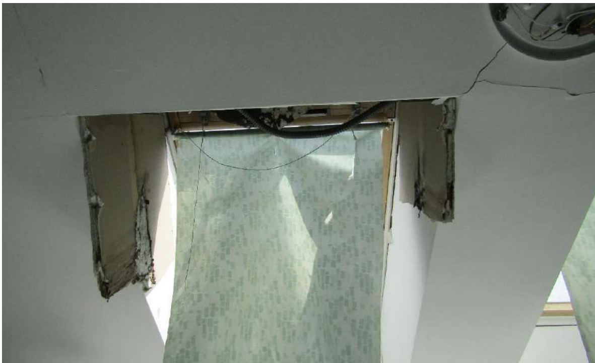
Рисунок 7.16 – Пошкодження віконного заповнення. Утворення тріщин по гіпсокартонному опорядженню стелі в осях Б-Г, 7'-8 (приміщення №21)
