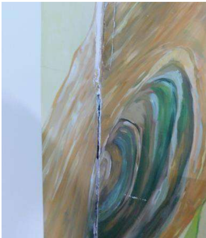
Рисунок 4.19 – Вертикальна тріщина по стику суміжних конструкцій стін на всю висоту поверху в осях Д-Е, 2-3 (приміщення №4)
