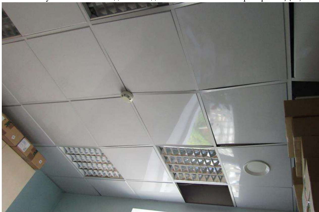
Рисунок 5.11 - Пошкодження підвісної стелі системи «Армстронг» Д-Е, 2-4
