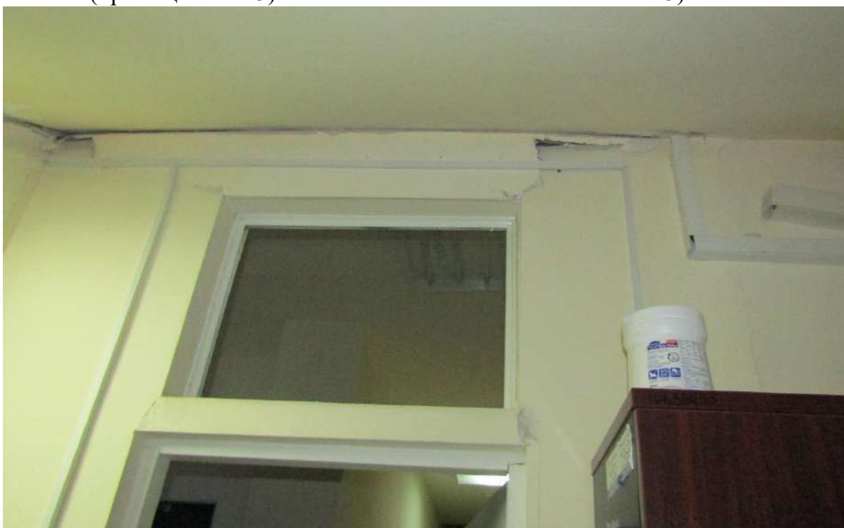
Рисунок 7.8 – Деформація опорядження перегородки в осях Б-Г, 2-3 (приміщення №3)
