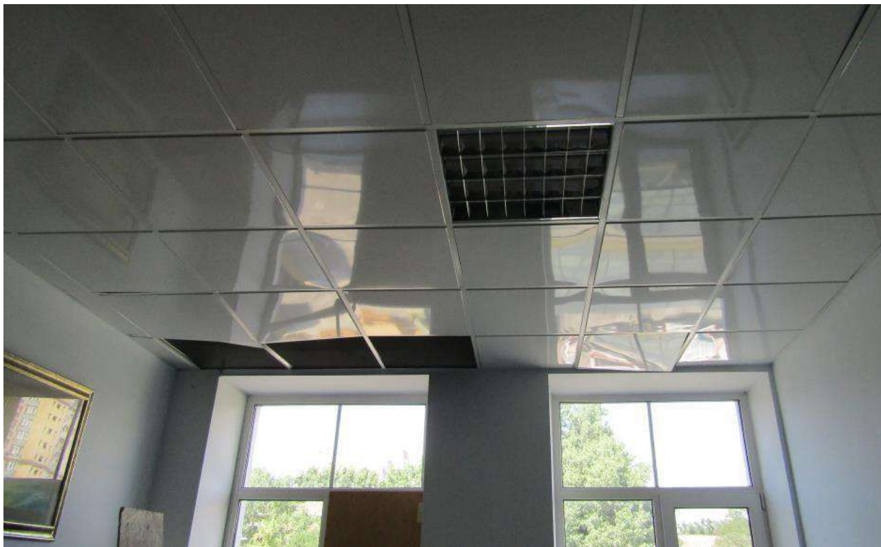
Рисунок 5.9 - Пошкодження підвісної стелі системи «Армстронг» Г-Д, 9-13
