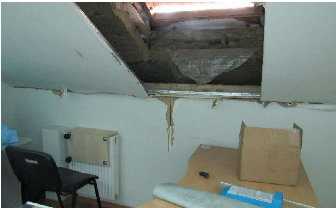
Рисунок 7.9 – Зруйноване/відсутнє віконне заповнення. Пошкодження гіпсокартонного опорядження стелі в осях Д-Е, 2-4 (приміщення №8)
