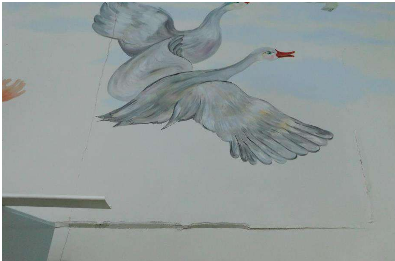
Рисунок 4.22 – Тріщини по гіпсокартонній перегородці в осях Д-Е, 2-3 (приміщення №4)
