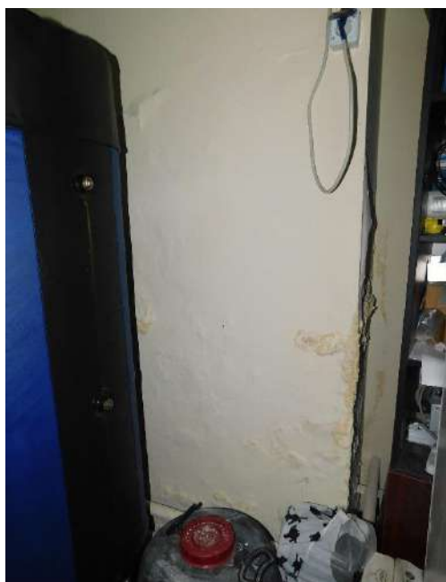
Рисунок 2.6 - Сліди замкнення, пошкодження поверхневого шару фарбованої поверхні стіни приміщення 77 в осях А-Б,15-16
