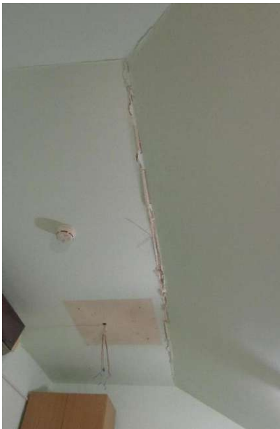
Рисунок 7.11 – Утворення тріщин по стиках гіпсокартонного опорядження стелі в осях Б-Г, 2-3 (приміщення №24)
