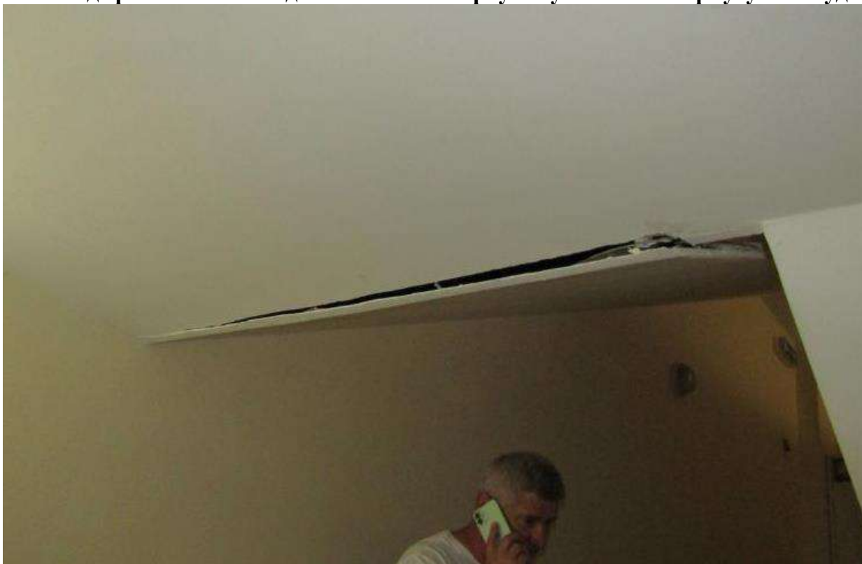
Рисунок 5.1 – Пошкодження гіпсокартонної підшивки стелі сходової клітини в осях Д-Е, 1-2
