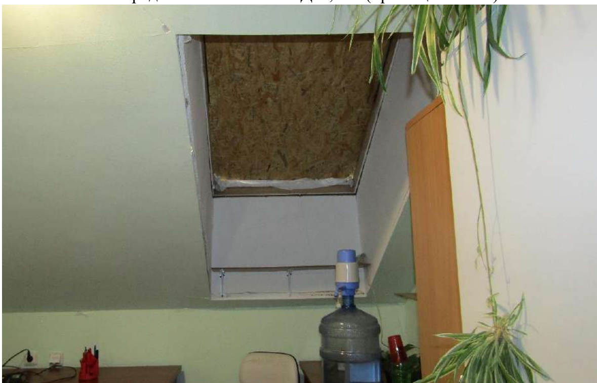
Рисунок 7.9 – Зруйноване/відсутнє віконне заповнення. Пошкодження гіпсокартонного опорядження стелі в осях Д-Е, 2-4 (приміщення №8)
