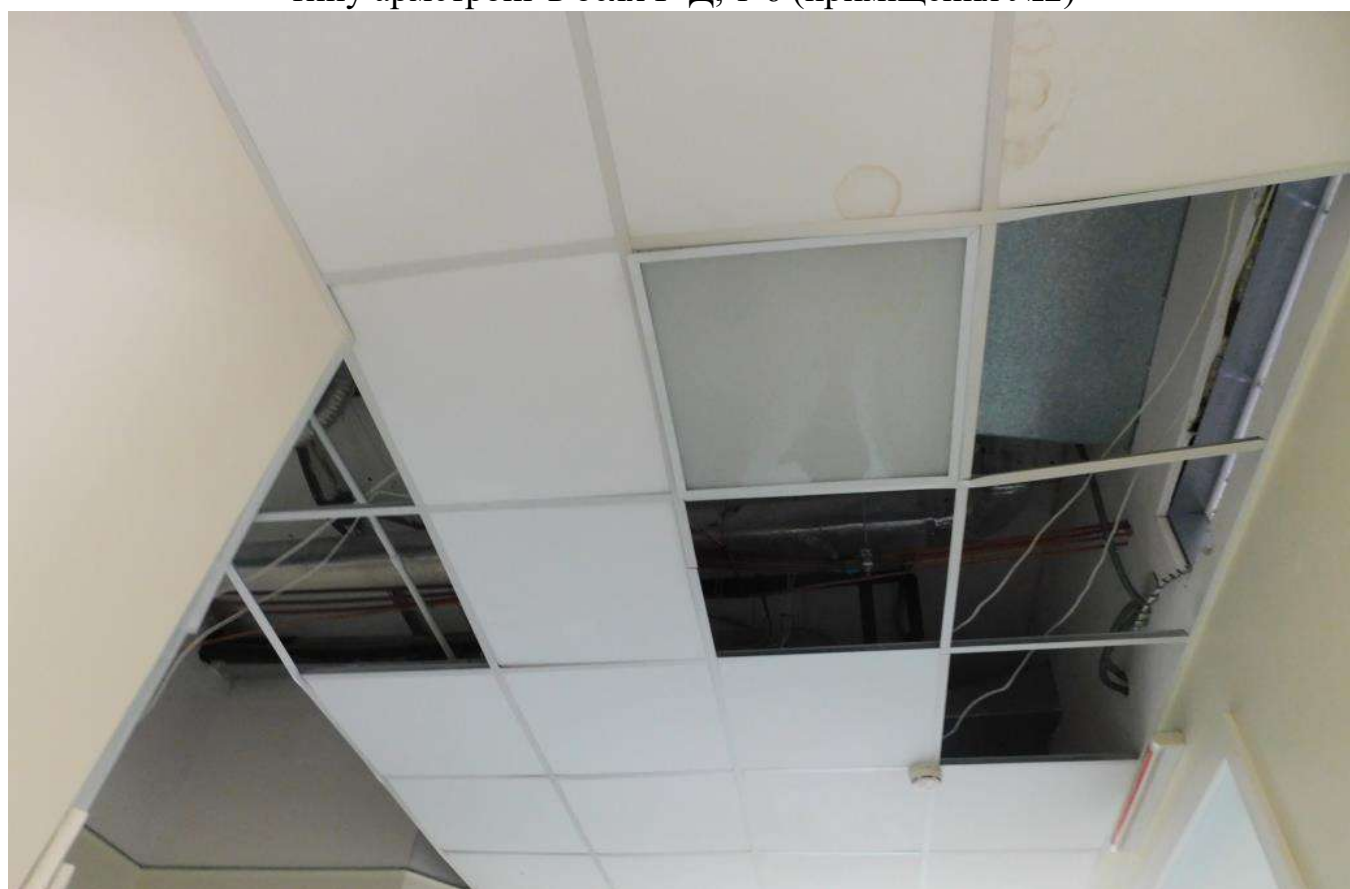
Рисунок 4.8 – Ділянка деформації/пошкодження системи кріплення підвісної стелі типу армстронг в осях Г-Д, 1-6 (приміщення №2)
