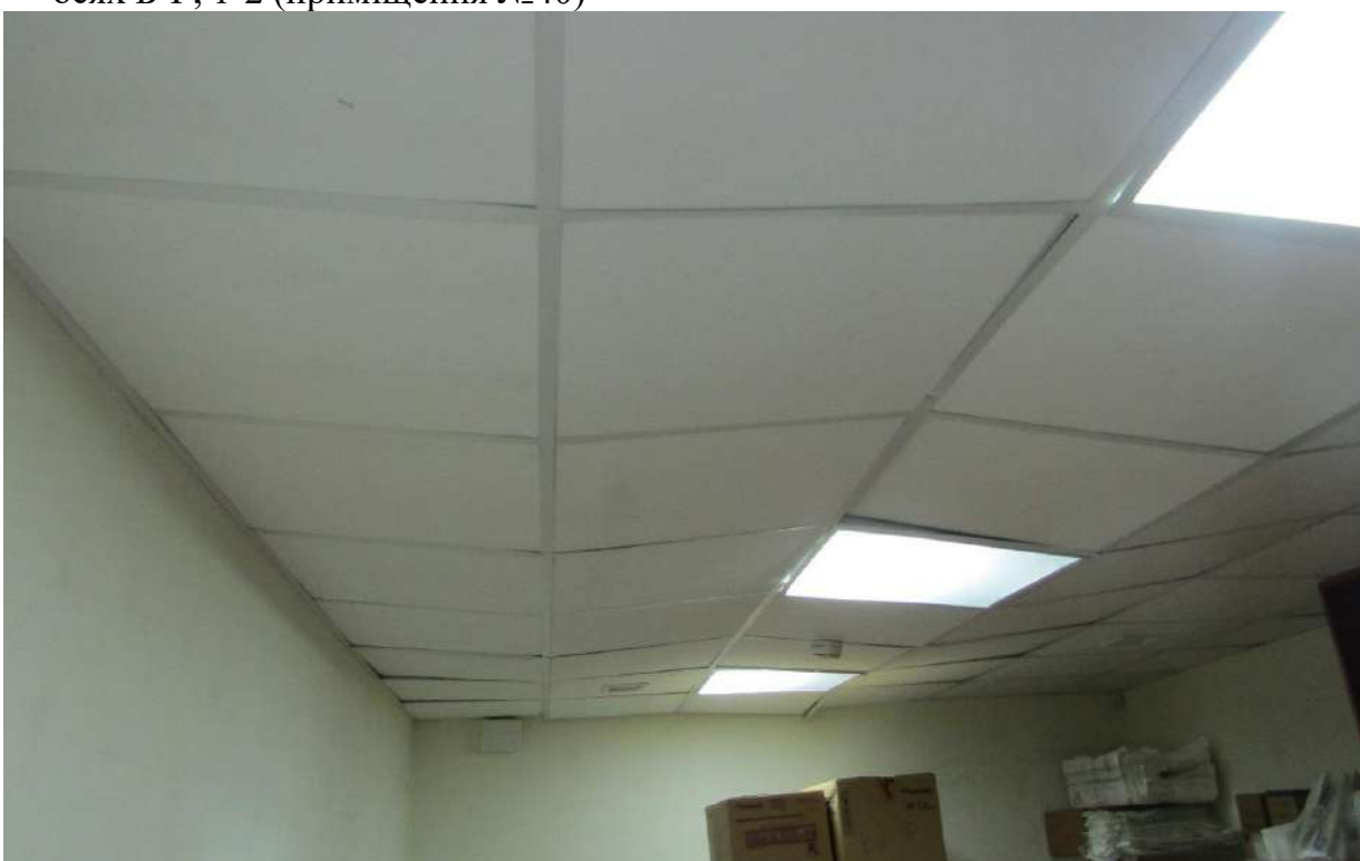
Рисунок 6.10 – Ділянка руйнування/пошкодження системи кріплення підвісної стелі типу армстронг в осях Б-Г, 1-2 (приміщення №40)
