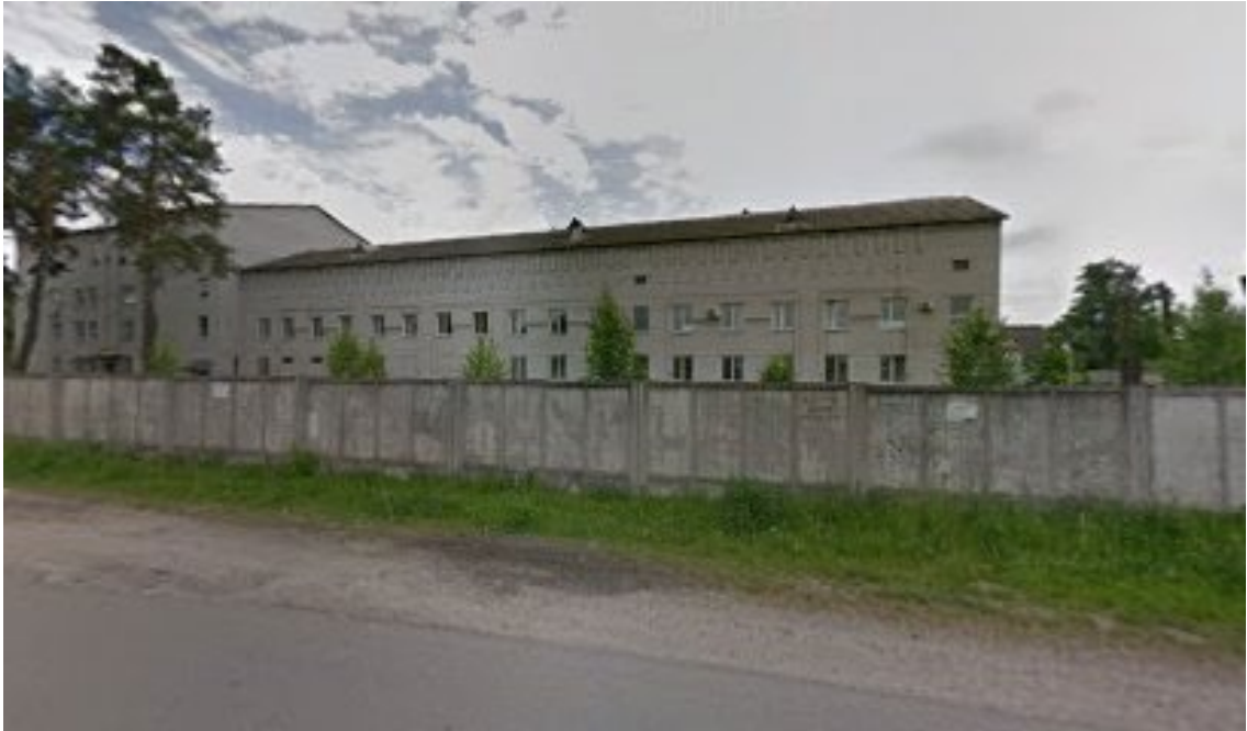
Рис. 4.1. Фото будівлі з проїзної частини вул. Марка Шляхового
